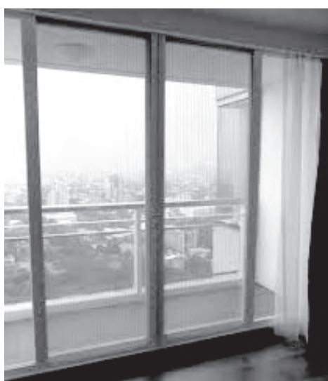
ภาพที่ 10.5 การติดมุ้งลวดที่ประตูทางเข้าบ้านเพื่อป้องกันบุคคลในบ้านจากการถูกยุงกัด ที่มา : สำนักโรคติดต่อฯ โดยแมลง
